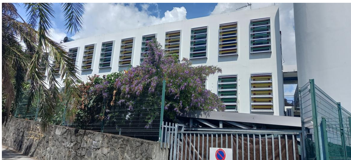
Mise en place de brise soleil
