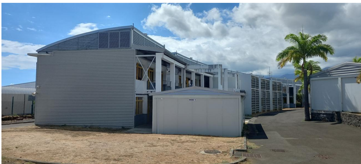
Isolation pignon bâtiment F – bardage métallique + isolation
