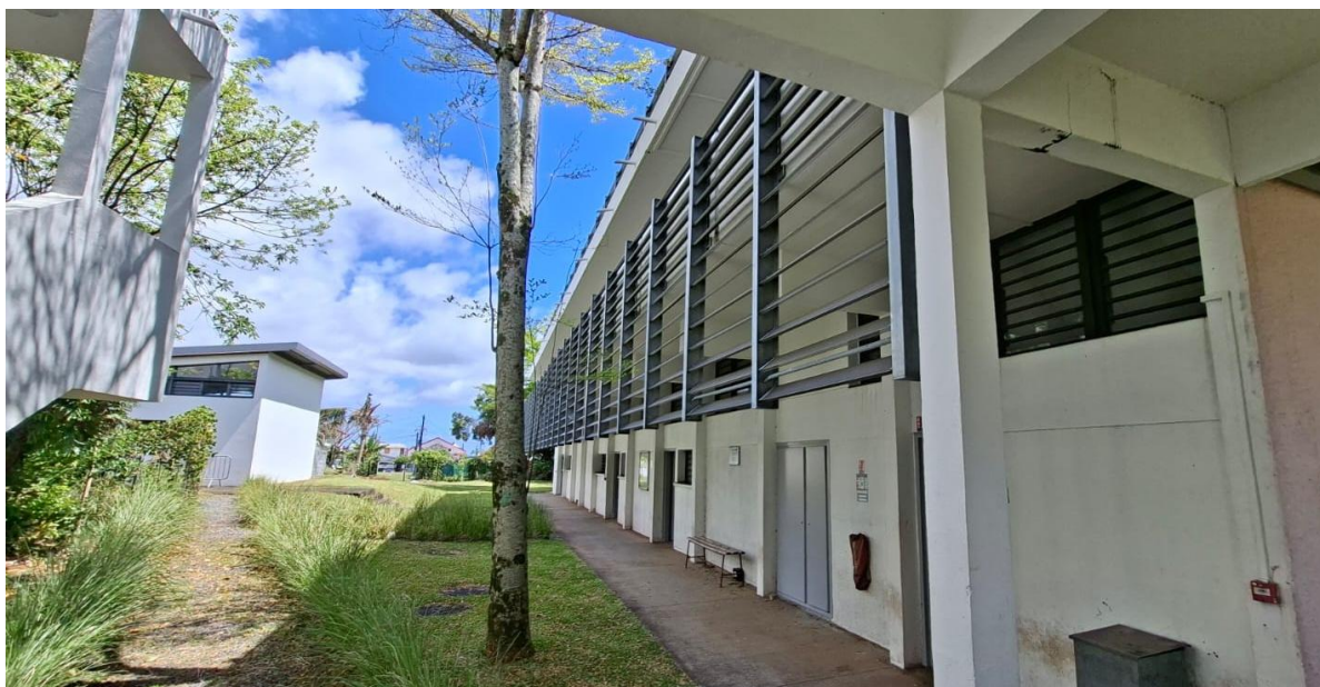
Mise en œuvre de brise-soleil sur le bâtiment D
