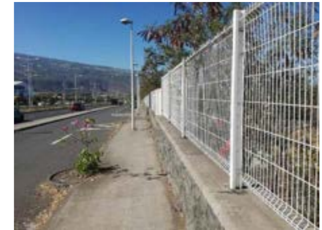
Figure 20 : exemple de mur de séparation le long de l'Axe Mixte (côté ouest)
