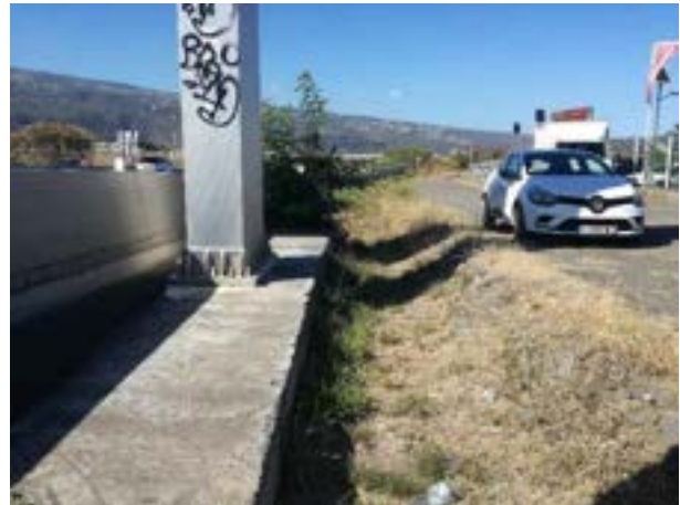
Figure 27 : fossé le long de la RN
