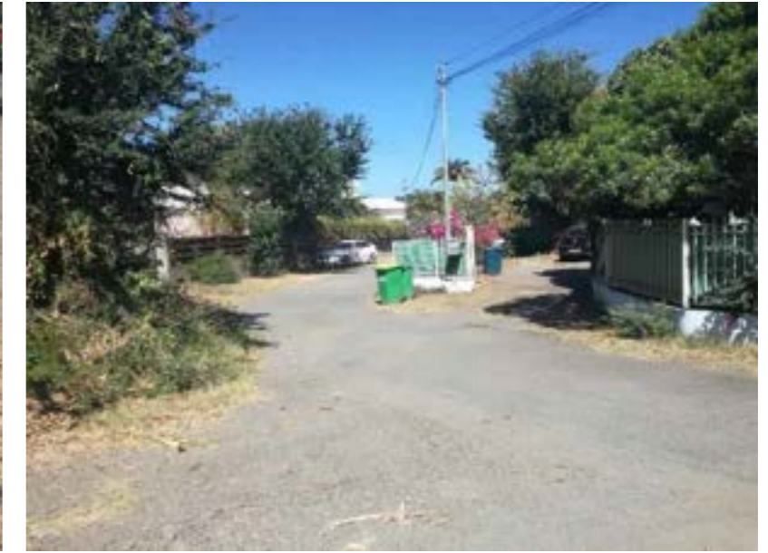
Figure 11 : fin de la canalisation des écoulements – écoulements sur la voirie
