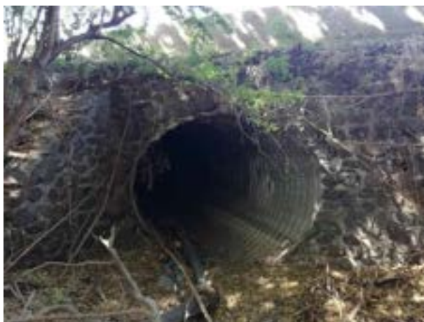
Figure 13 : buse sous la RN1 vue de l'aval
