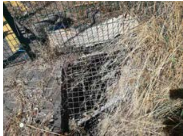
Figure 24 : amont de la buse sous le site URCOOPA
