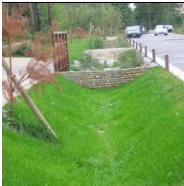
Figure 145 : Exemple de noue pluviale munie de cloisons
