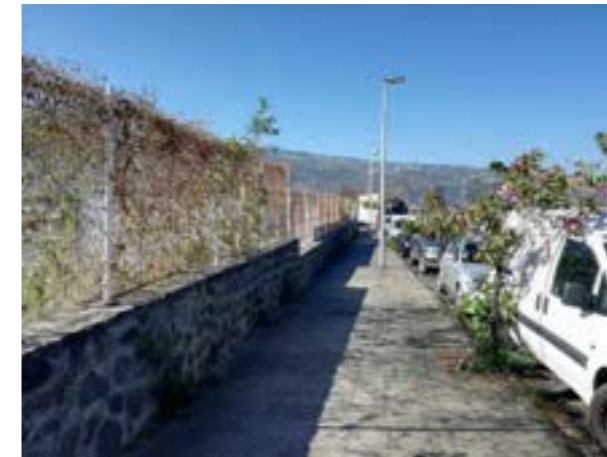
Figure 19 : exemple de mur de séparation le long de l'Axe Mixte (côté est)
