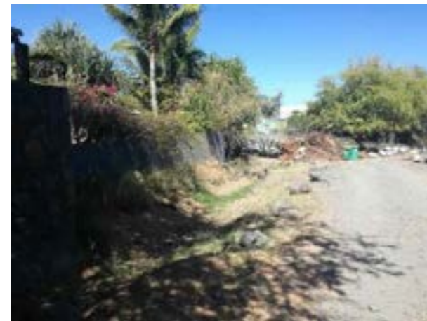
Figure 7 : vue en aval de la buse
