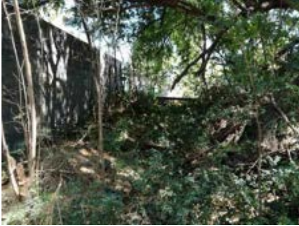
Figure 15 : aval de la zone de rétention et fossé exutoire
