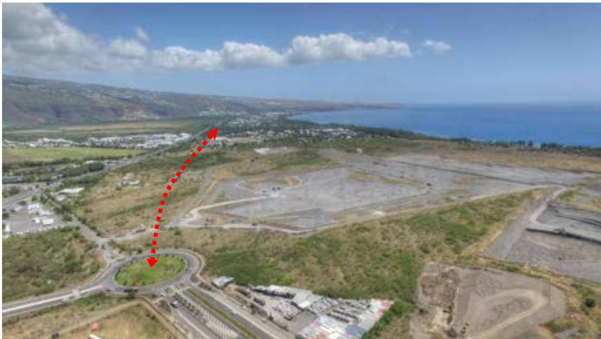
La plaine de Cambaie – échelle immédiate – travaux de carrière en cours
