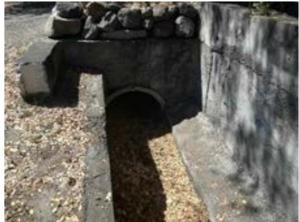
Figure 20 : buse depuis l'aval
