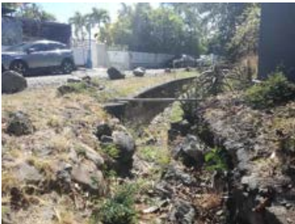
Figure 17 : vue en amont de la buse
