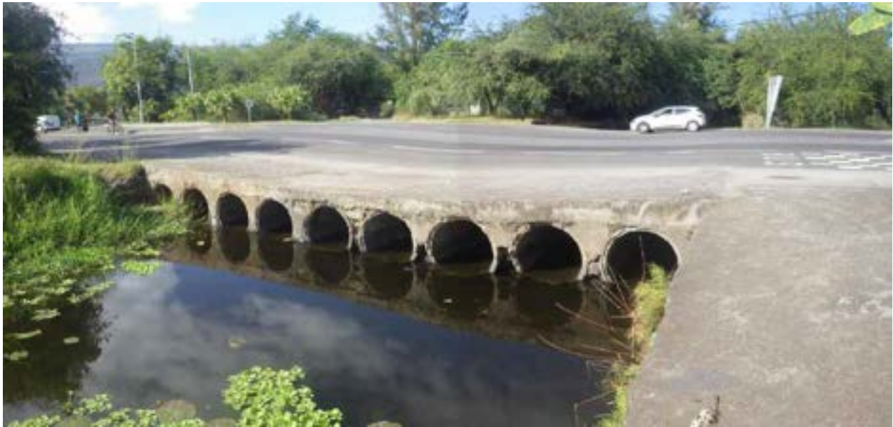
Figure 180 Le passage en radier à l'état initial
