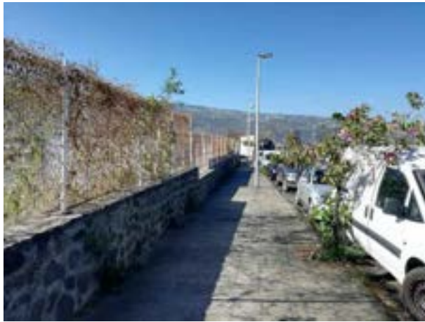
Figure 30 : exemple de mur de séparation le long de l'axe Mixte (côté est)
