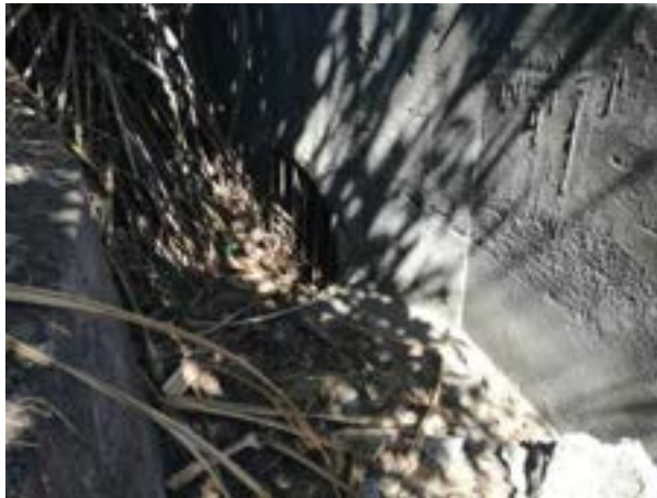
Figure 19 : buse depuis l'amont
