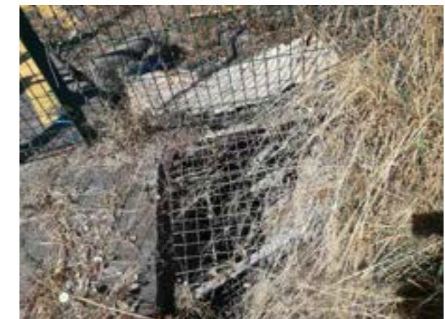
Figure 13 : amont de la buse sous le site URCOOPA
