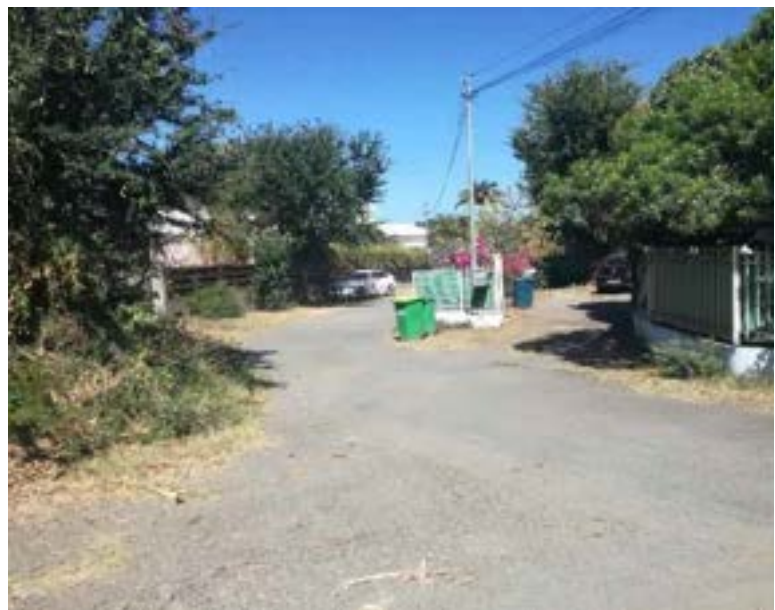
Figure 22 : fin de la canalisation des écoulements – écoulements sur la voirie
