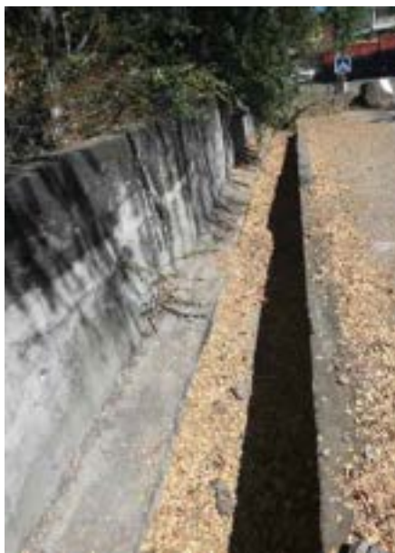
Figure 21 : buse sous la RN1 vue de l'aval
