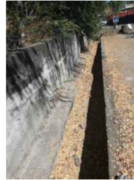
Figure 10 : buse sous la RN1 vue de l'aval
