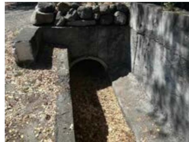
Figure 9 : buse depuis l'aval
