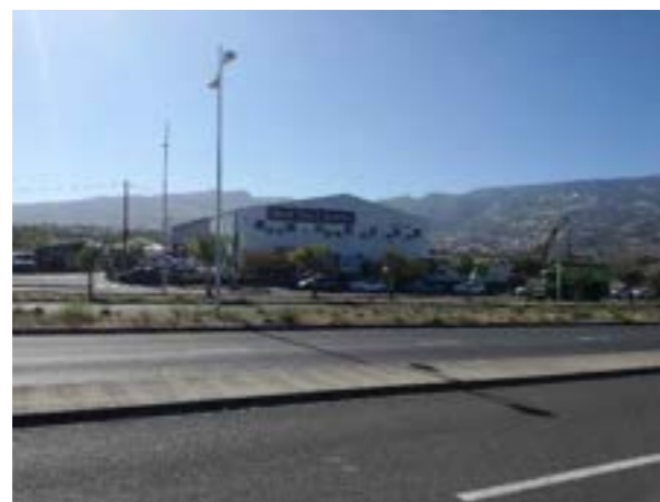
Figure 23 : séparateur central de chaussée
