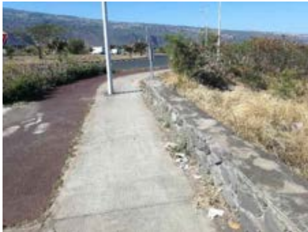
Figure 33 : fin du mur côté ouest – rond-point de Cambaie
