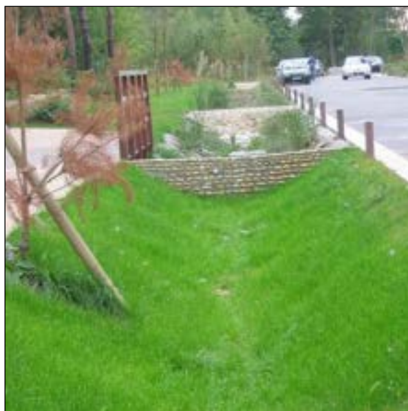
Figure 117 : Exemple de noue pluviale munie de cloisons
