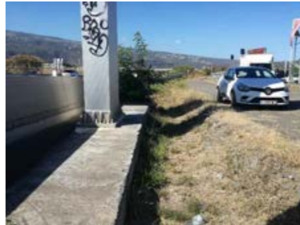
Figure 16 : fossé le long de la RN
