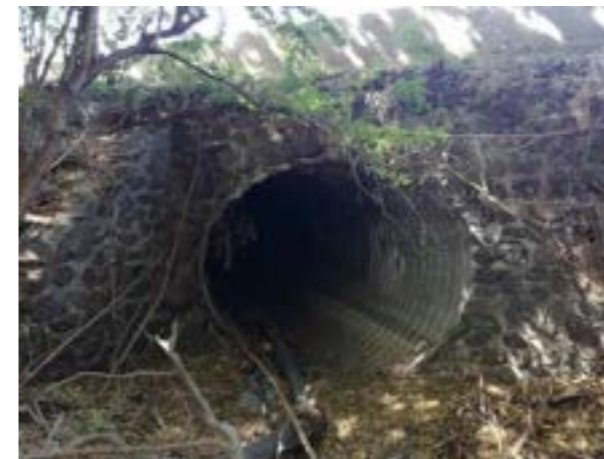
Figure 2 : buse sous la RN1 vue de l'aval
