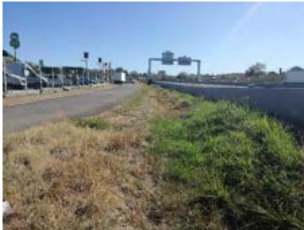
Figure 26 : fossé le long de la RN
