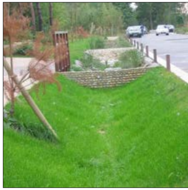
Figure 131 : Exemple de noue pluviale munie de cloisons
