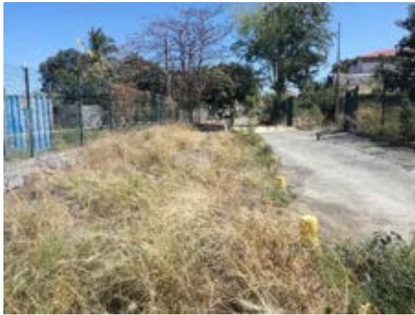
Figure 23 : fossé au niveau du site URCOOPA
