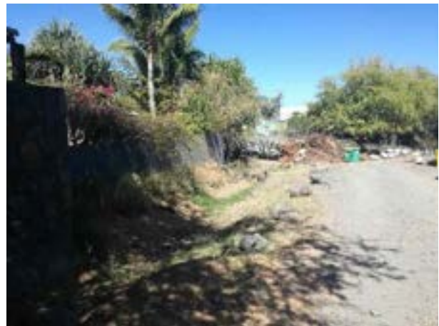
Figure 18 : vue en aval de la buse
