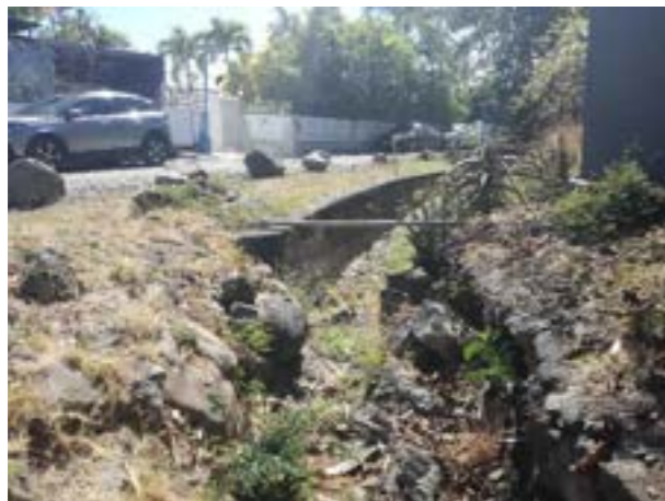
Figure 6 : vue en amont de la buse
