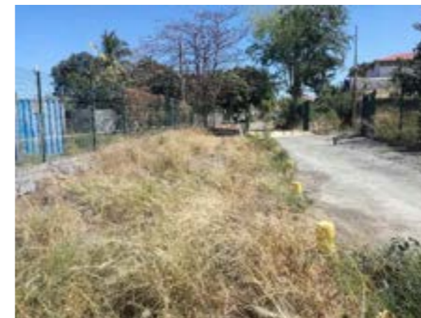
Figure 12 : fossé au niveau du site URCOOPA
