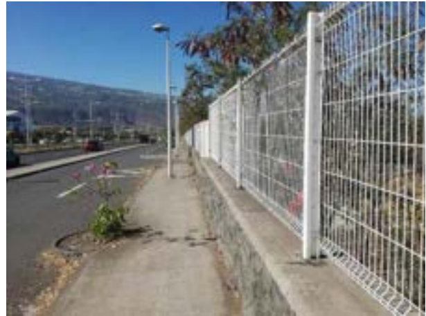
Figure 31 : exemple de mur de séparation le long de l'axe Mixte (côté ouest)
