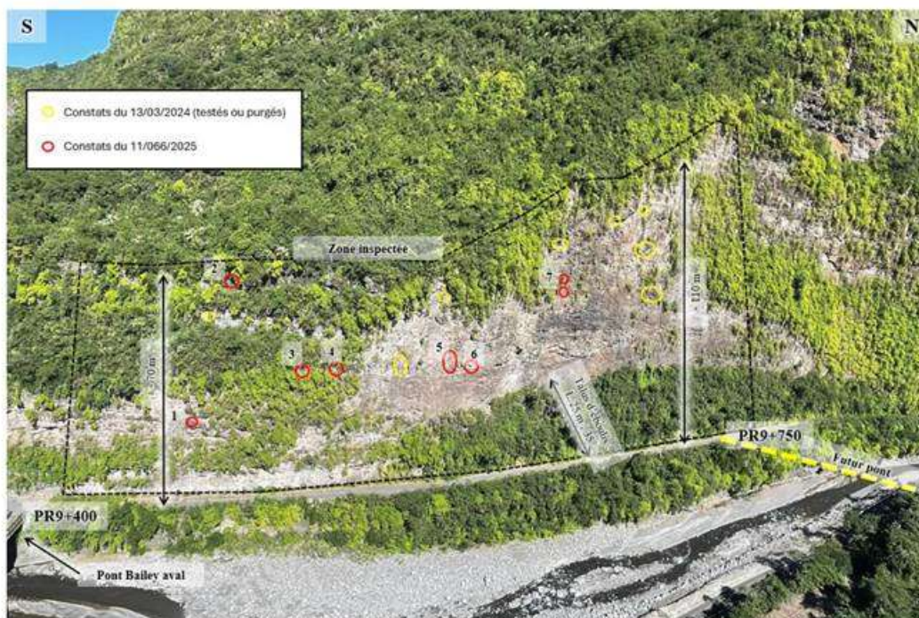
Figure 2. Emprise de la zone sur laquelle serait appliquée la méthode RIDIM dans le cadre de cette action (PR9+400 au PR9+750 de la RN5).
