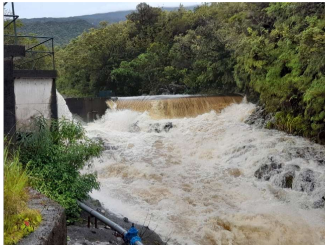
Photo 1 : Captage du Bras des Lianes
