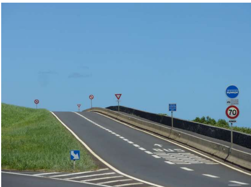
Illustration 2: Voie réservée aux transports collectifs et Voie Vélo Régionale à Sainte-Suzanne RN2
