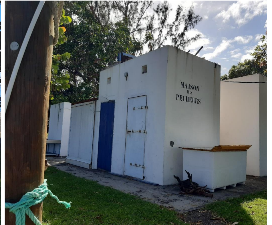
Box de stockage
