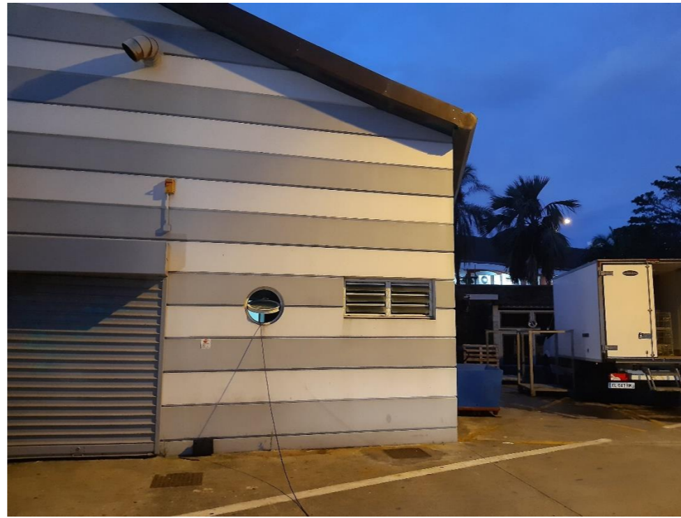
Local destiné à accueillir la machine à glace et la chambre froide
