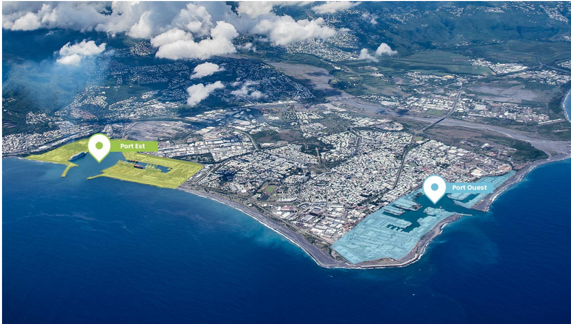
Figure 3 : Vue aérienne du Grand Port Maritime de la Réunion
