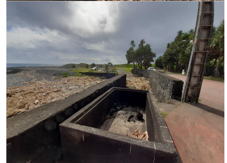
Rampe d'accès à la marine
