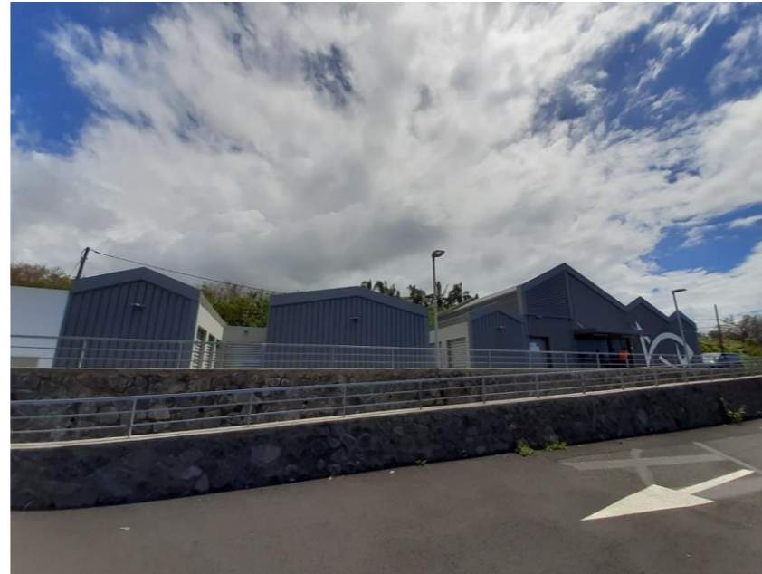
De g. à d. (cf. plan à droite) : Local EDF, box pêcheur, halle de vente et gardiennage, laboratoire, chambre froide
