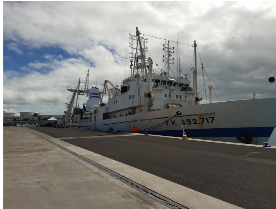
Poste P1 reconstruit en 2022
