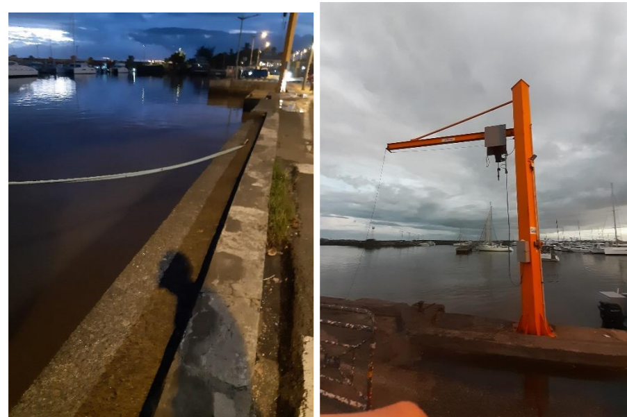
Largeur des quais limitée et potence de déchargement installée
