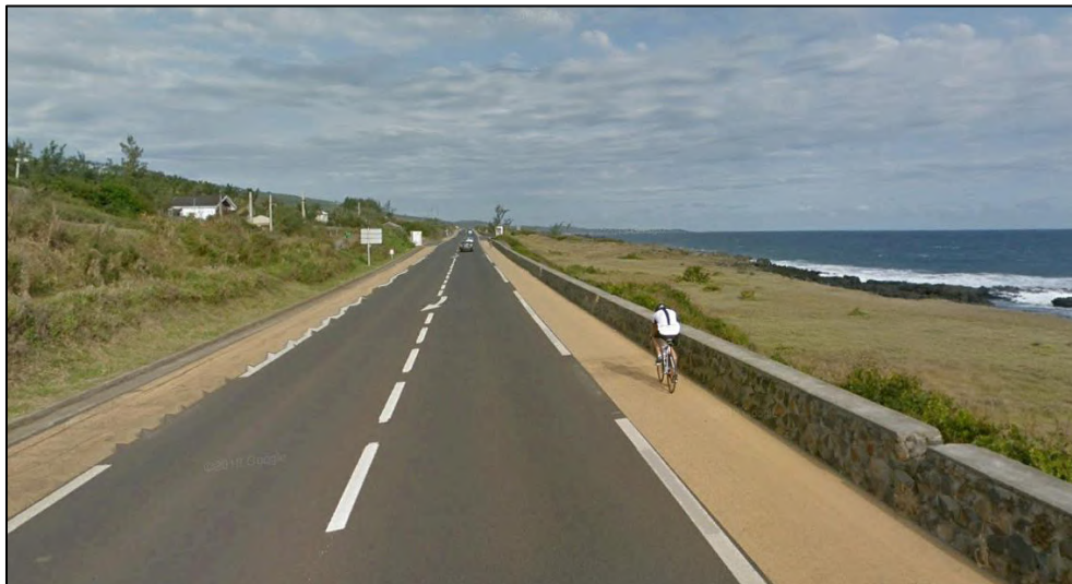
Figure 6 : VVR sur la N1A – Image Google Earth
