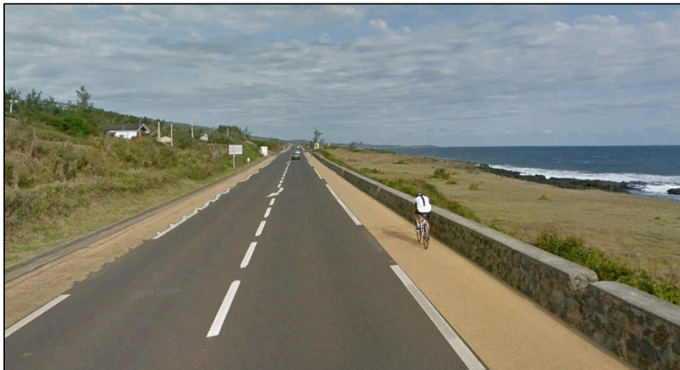
Figure 6 : VVR sur la N1A – Image Google Earth
