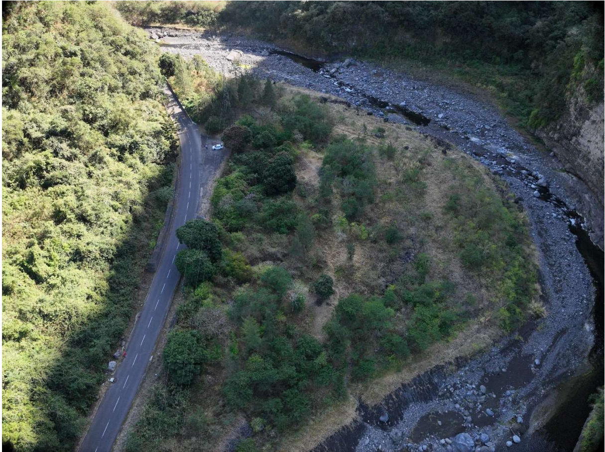
Prise de vue aérienne du site de l'Ilet Cafres (commune de Saint-Louis)
