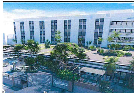
Le nouveau Radisson Blu 4 étoiles après travaux
