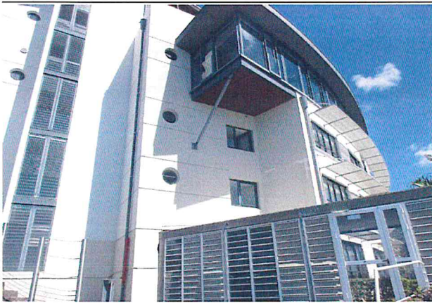
niveaux inférieurs du bâtiment (RDC bas à R-3)
