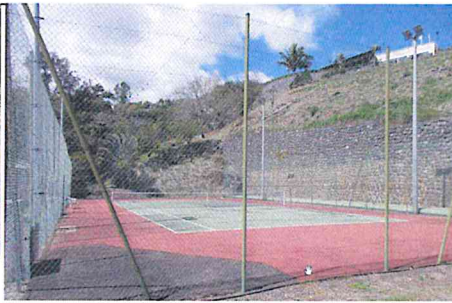
court de tennis et talus soutenu par enrochement
