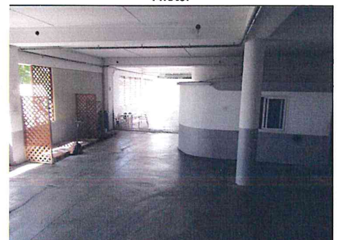
Niveau technique donnant accès aux cuisines de l'hôtel
