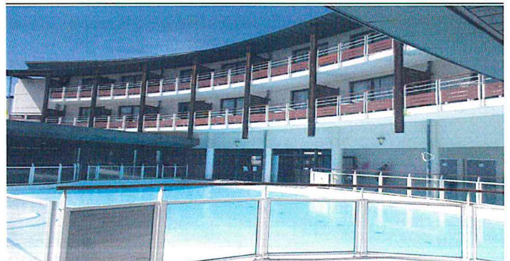
vue vers les étages supérieurs depuis le deck de la piscine
