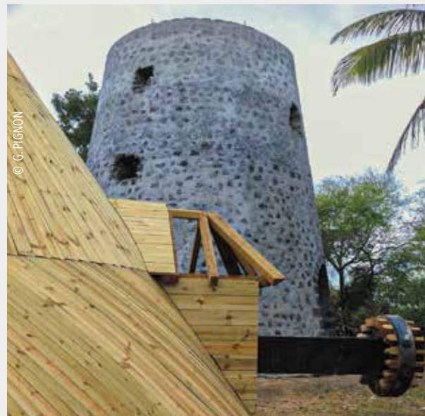
➊ Moulin du domaine du Chaudron avant restauration.
