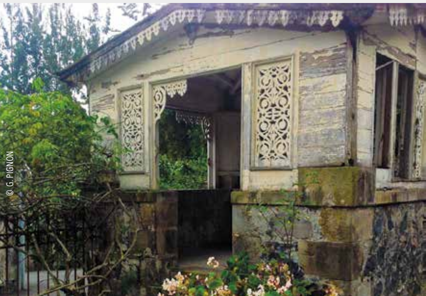
➊ Guétali de la maison Lucilly avant restauration.
