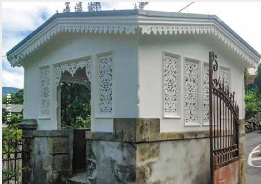
➋ Guétali de la maison Lucilly après restauration.
